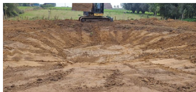
AANLEG EN HERSTEL VAN POELN
